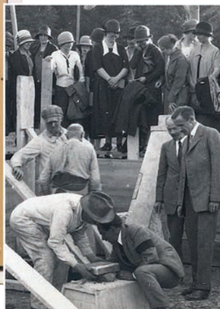
Pose de la Bible dans les fondations
